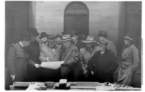
03 Innenminister Josef Seyfried (1.R.4.v.l.) und Philipp Auerbach (1.R.5.v.l.) nahmen an einer Besprechung zum Umbau der Synagoge inmitten der Baustelle teil, München 9. Oktober 1946 DE-1992-FS-STB-7865 / Stadtarchiv München
